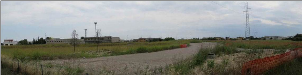
Figura 13 – Cantiere nuova bretella “Valdaro – casello Mantova Nord”
