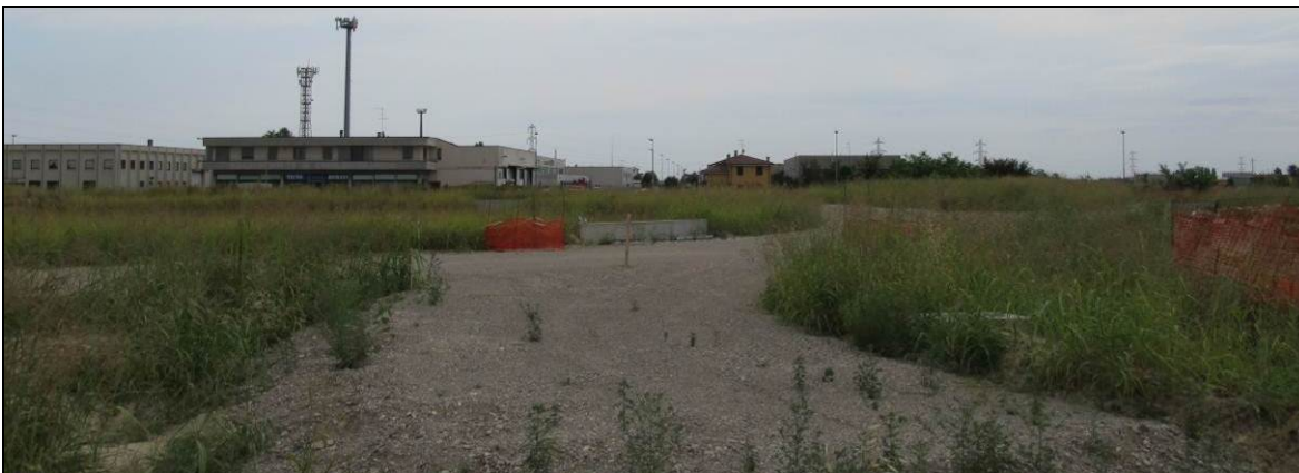
Figura 14 – Cantiere nuova bretella “Valdaro – casello Mantova Nord”
