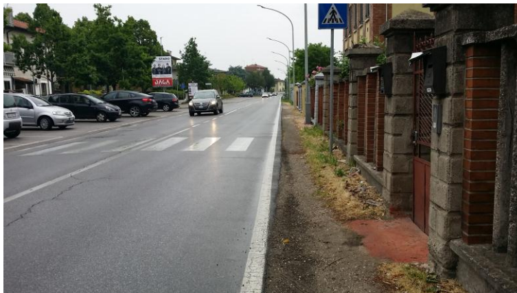
Banchina da pavimentare sul lato est
