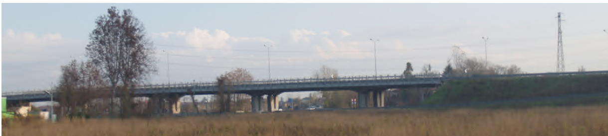
Fig. 25 Dominanze vedutistiche – Tangenziale sopraelevata
