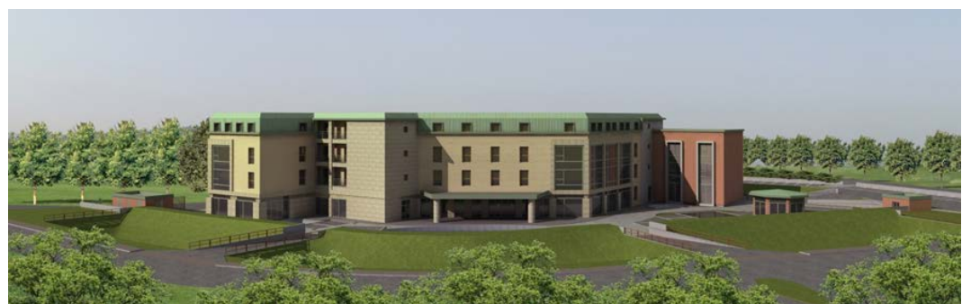
Vista da Strada Lunetta
