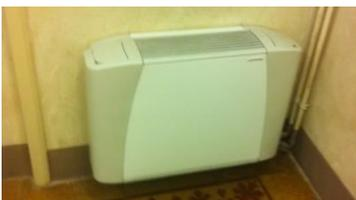
I **ventilconvettori**, conosciuti anche come fan-coil, sono dei terminali impiantistici caratterizzati da un elevato livello di efficienza energetica grazie alla velocità con cui riscaldano gli ambienti (se dimensionati correttamente) e alla bassa temperatura del fluido termovettore.
